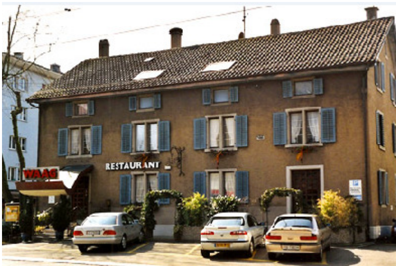
Restaurant zur Waag, Schaffhauserstr. 413, 8050 Zürich (1898, 2003 u. 2010)
